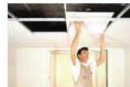
4 Colocación de placa
