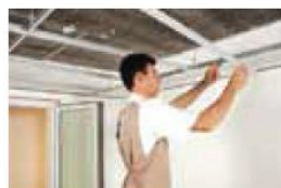
3 Colocación de T secundarias.
