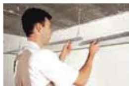
2 Colocación de T principal.
